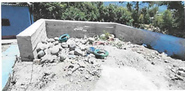
Foto 5: muro perimetral de piedra
