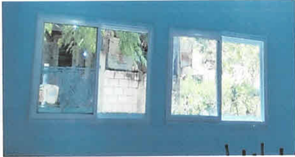
Foto 1: Colocacion de ventana pvc
