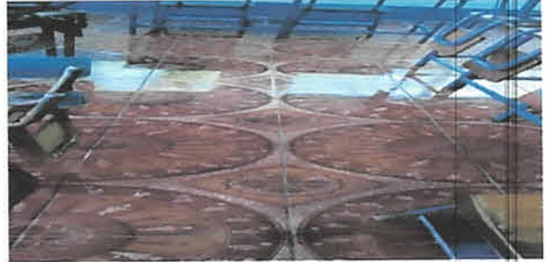
Foto 2: Instalacion de piso
