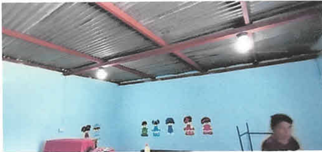
Foto 3: Cambio del sistema electrico
