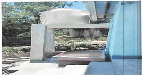
Foto 6: Instalacion del tanque de agua
