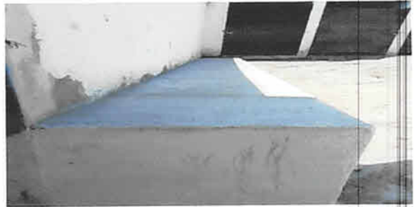
Foto 4: Elaboracion de banqueta de mposteria
